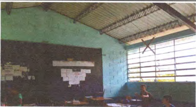
Foto 3: Aplicación a dos manos de pintura en interior del establecimiento.
