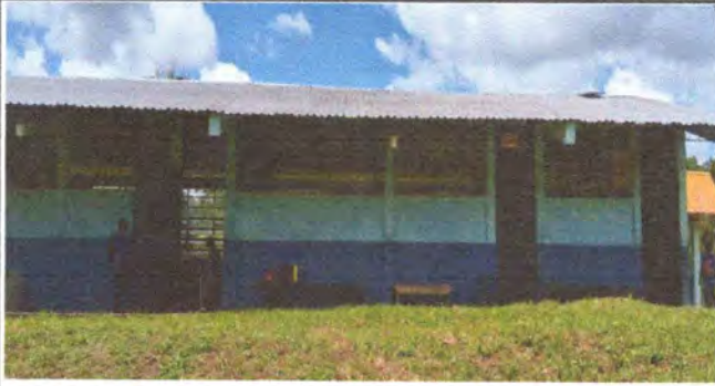
Foto 1: Desmontaje de estructura de metal por deterioro y cubierta de lamina.
