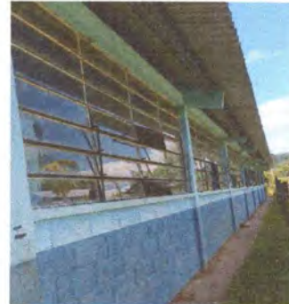
Foto 2: Montaje, instalación y suministro de estructura metalica y laminas troqueladas.
